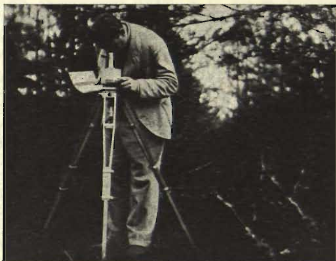
Fig. 4. Novērošana ar Schmidt'a vertikāliem magnetiskiem svāriem Askania tipa Gf7.
