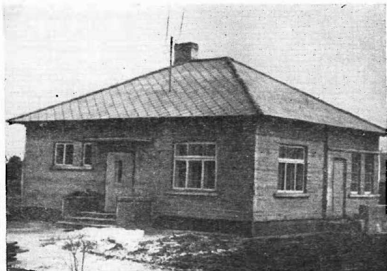
Рис. 6. Дом из опилочного бетона в Слоке в 1957 г., с применением романцемента.
