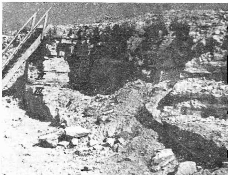
Рис. 1. II и III пласты Слокского доломитового мергеля, используемые для производства ромашцемента.
