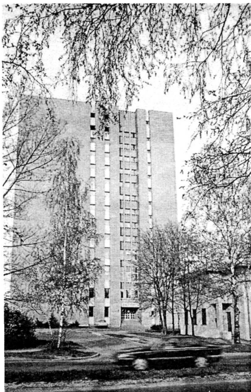
Bibliotēkas ēka Lielvārdes ielā 24.
