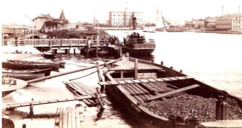
Agenskalna līcis Rīgā. 20. gs. sāk. Fotogrāfs E. Egerts, Rīga.
