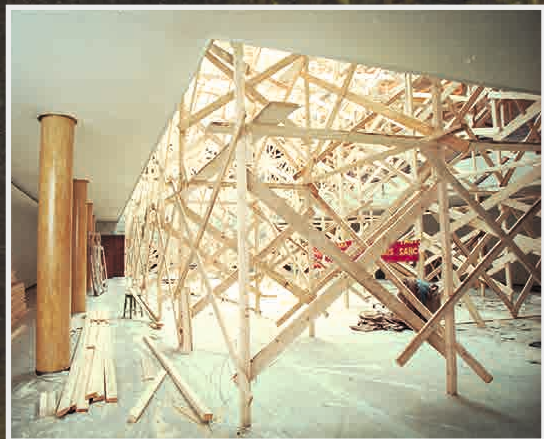
Remonts LU Lielajā aulā. 1999. gads Renovation of the UL Great Hall. 1999
