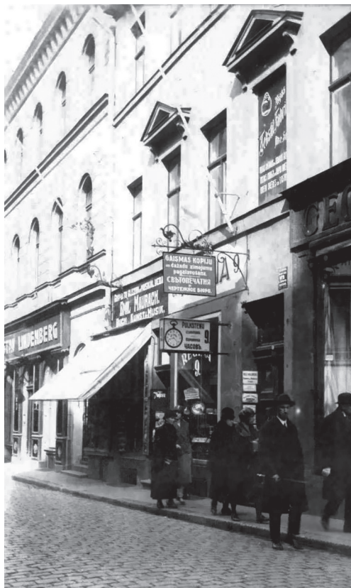
Проектная контора и светопечатня В.М. Шервинского. Сарайная (Шкюню) улица, д.9. Фотография В.М. Шервинского
