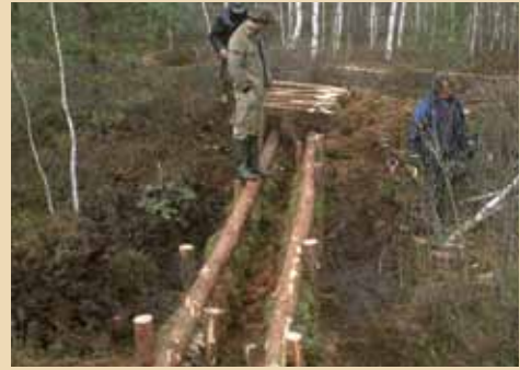
54. attēls. Aizsprosta profilā izveidotas un nofiksētas divas pilna augstuma baļķu rindas dabas lieguma „Lubāna mitrājs” Salas purvā
