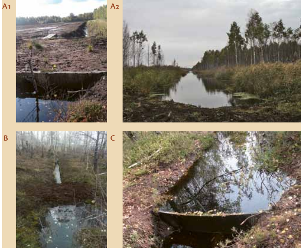
66. attēls. Dažādi dambju veidi, kas būvēti uz Aukštumalas augstā purva novadgrāvjiem: A – koka/kūdras dambji, B – nelieli kūdras aizsprosti, C – nelieli bērza finiera dambji
