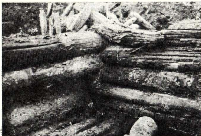
10. att. 27. ēkas krusta pakšis. Skats no iekšpuses.
