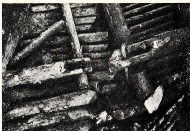
9. att. Jūgkoki ēku stūru savienojumos. 1 — 33. ēkas ziemeļrietumu stūris; 2 — 40. ēkas dienvidrietumu stūris.
