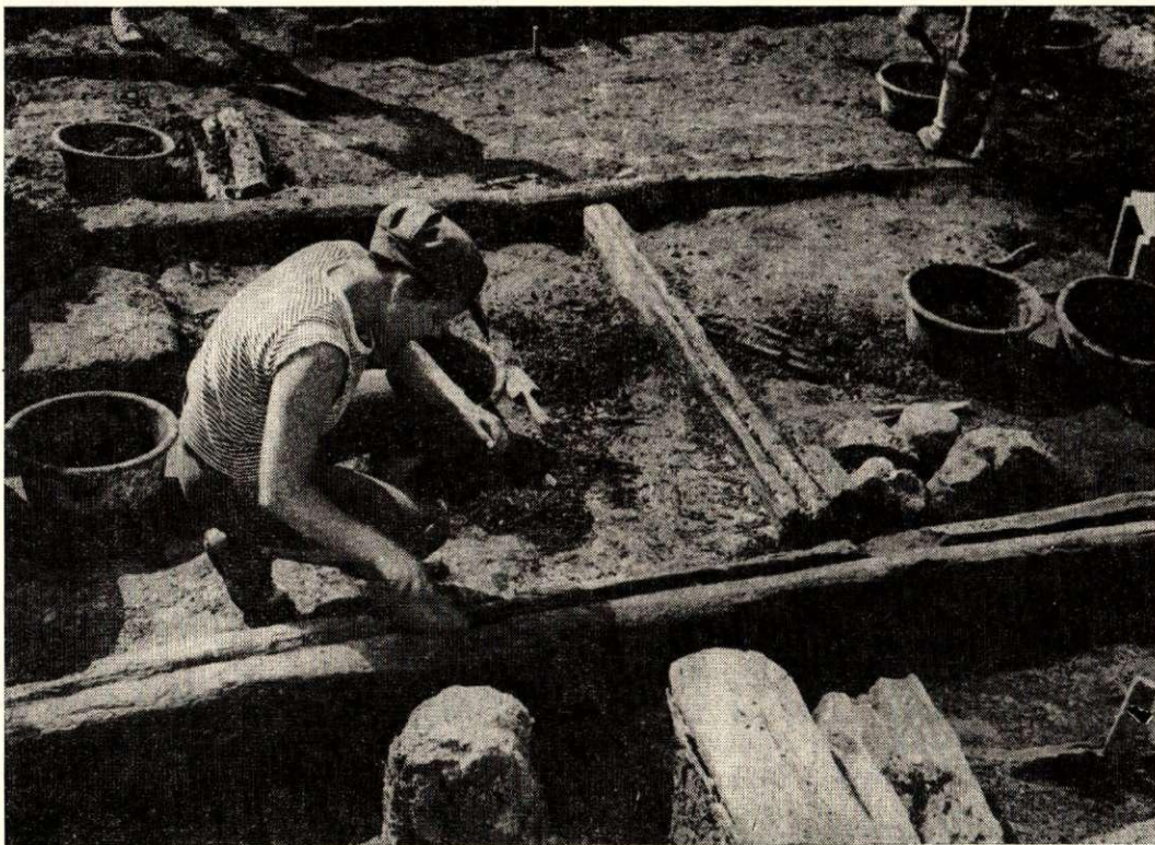
41. att. Pildrežģu ēkas apakšējo sienas vainagu atrakšana Daugavas ielā.
