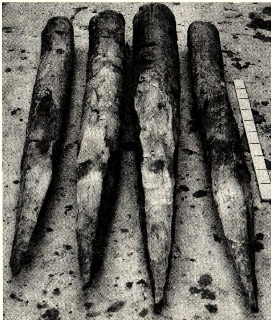
15. att. Izrakumos no Rāmera torņa pamatnes izņemtie koka pāļi.
