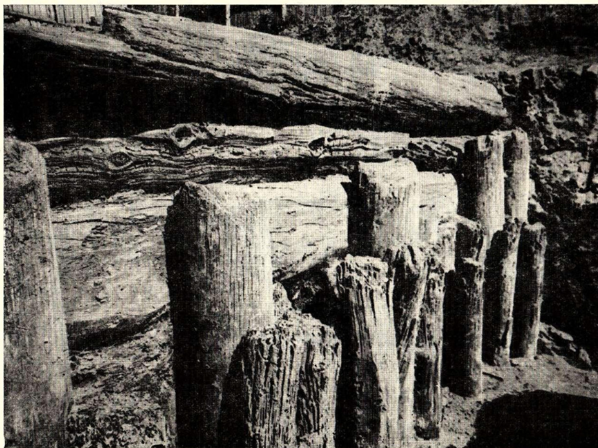
5. att. 13. Janvāra ielā atsegtie 15.—17. gs. Rīgas upes krasta nostiprinājumi.
