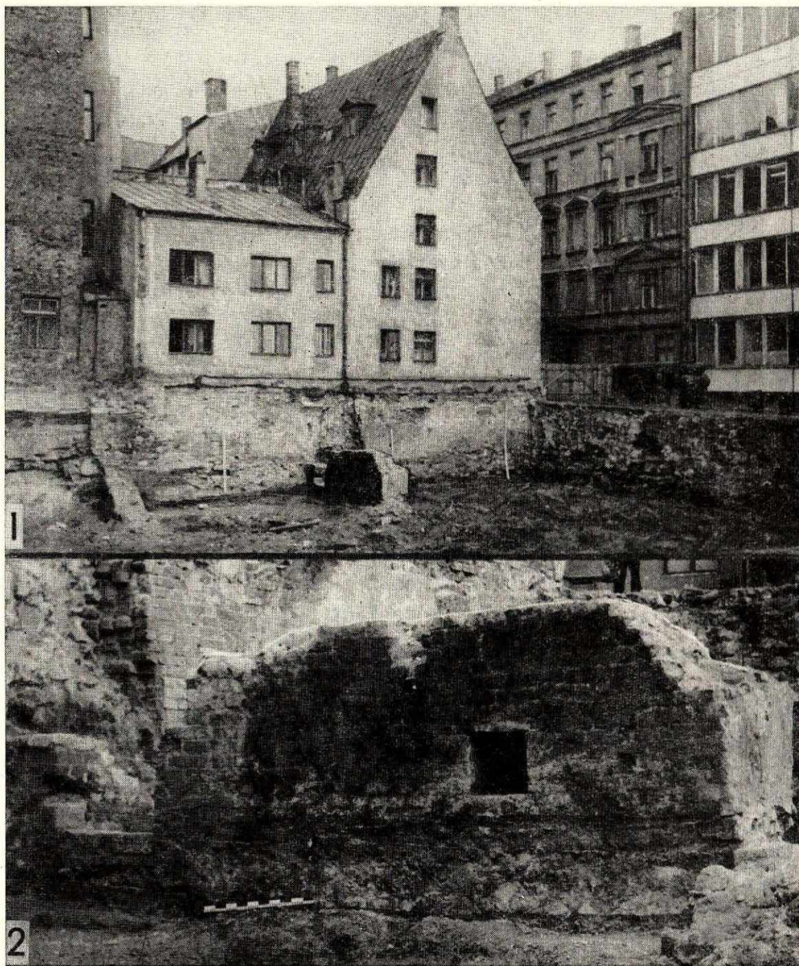
36. att. Peldu un Ūdensvada ielas izrakumos atsegta 13.—14. gs. mūra ēka. 1 — kopskats uz izrakumu vietu, 2 — celtnes vieta tuvplānā.
