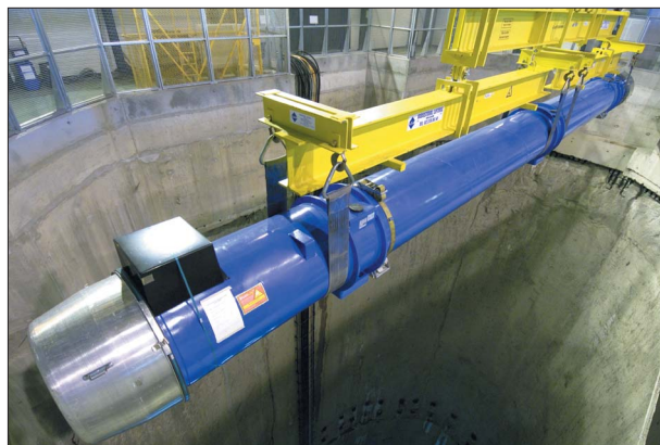
Pedējā dipolu magnēta nolaišana tunelī. CERN foto
