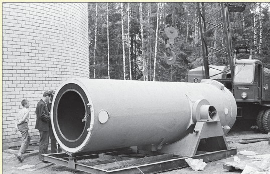
21. att. Teleskopa tubuss sagatavots pacelšanai tornī.
