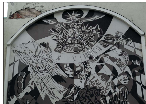
Sgraffito tehnikā veidots vertikālais saules pulkstens muzeja pagalmā.
