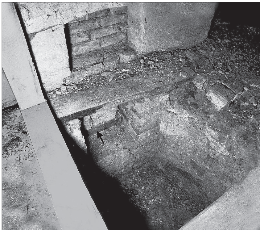
1. att. Rīgas pils Svina torņa bēniņu stāvs. No ārpusē aizmūrētā šaujamlūka ar tās apakšdaļā daļēji redzamo vaļņu bises balsta ozolkoka pamatni (norādīta ar bultiņu)
