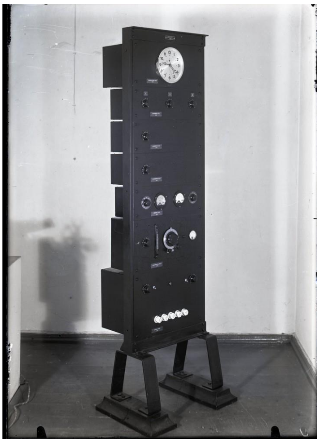
30. attēls. A. Akmentiņa kvarca pulkstenis. Skats no sāniem. 1939. – 1944. gads.
