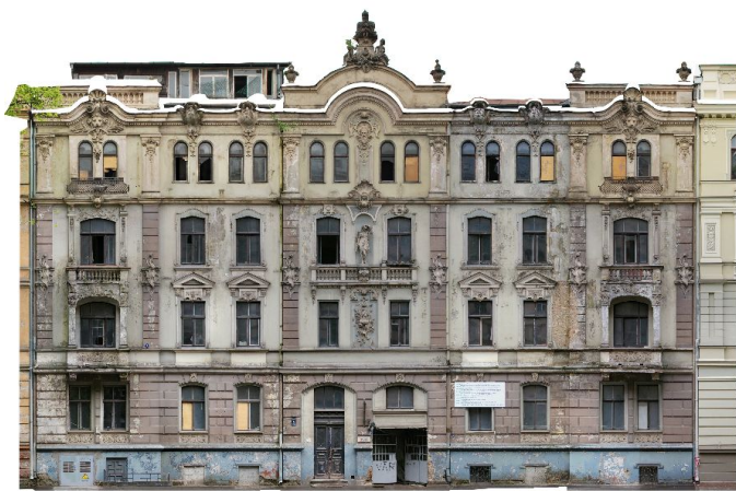
1. attēls. Izgatavotā ortofoto piemērs (Ausekļa iela 4, Rīga)
