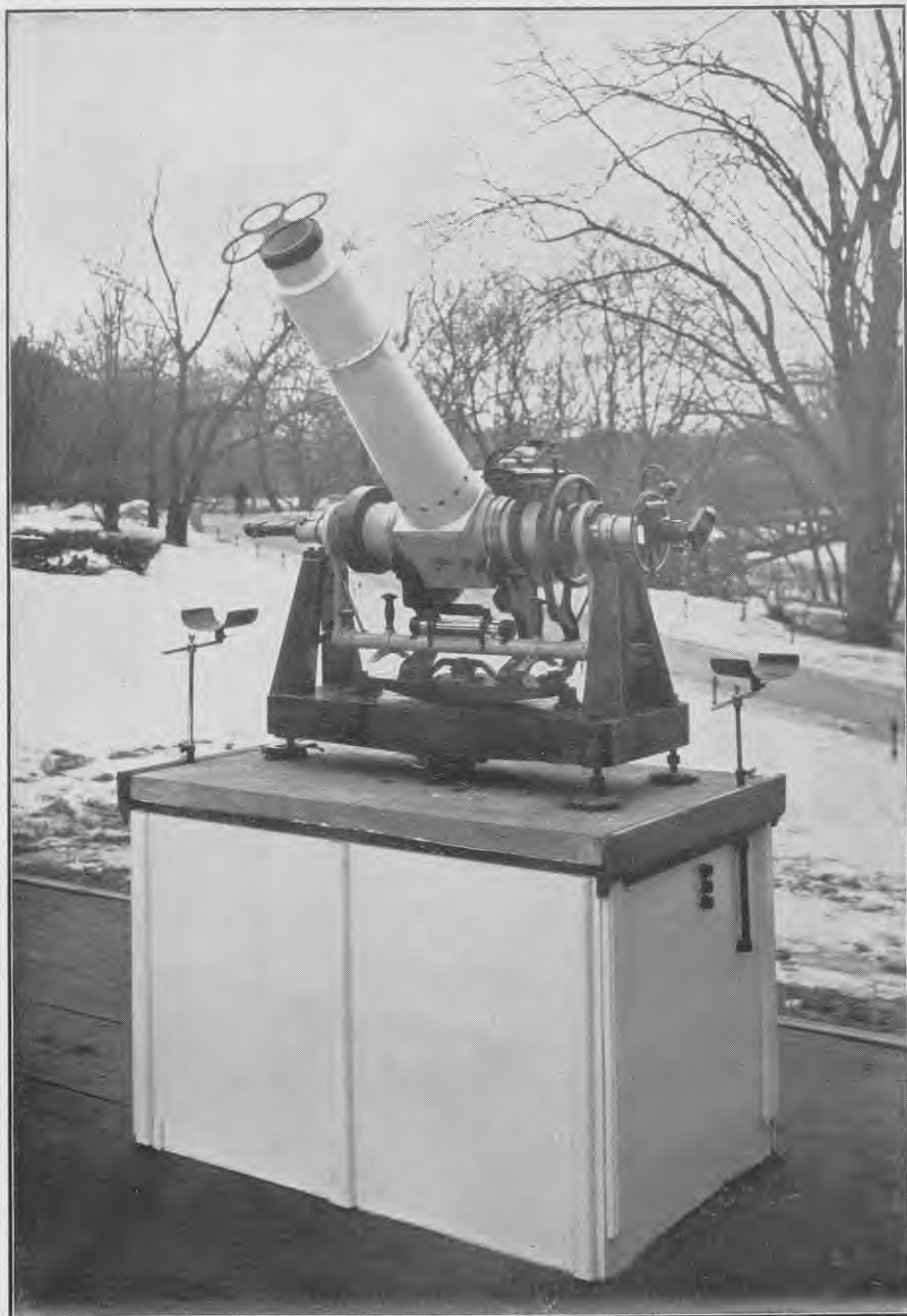
Fig. 13. Das grosse Passageninstrument.
