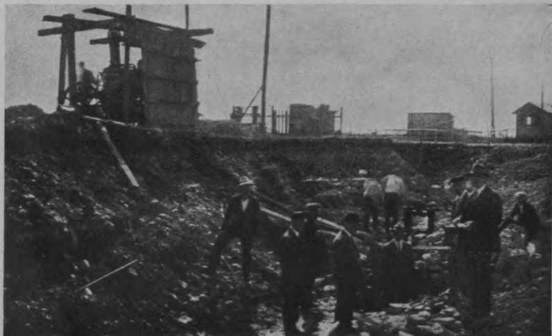
1. attēls. Pa labi sūkņu ēka un uzbērums, pa kreisi Slokas celulozas fabrikas 3" tvaika sūknis, vidū aka
