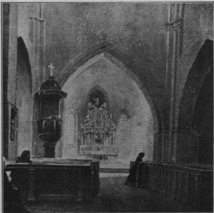
1. att. Rīgas Jekaba baznīcas altāra telpa 1855. g. Pēc kāda K. Šulca aķvareļa, kas atrodas Kurzemes provinciālmūzejā, Jelgavā.
