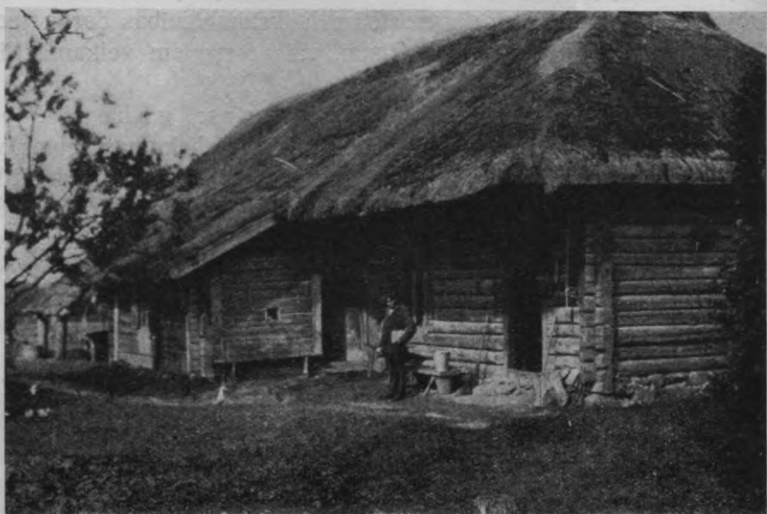
52. att. Rg. Vidrižu Ausiņi. A.
